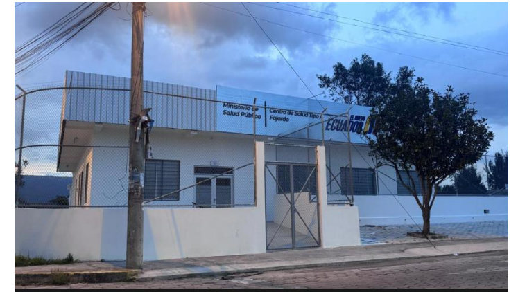
Repotenciación Centro de Salud Tipo A Fajardo (Fachada principal)
