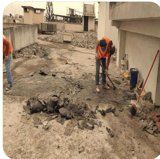
LEVANTAMIENTO DE CERAMICA DE PISOS Y PAREDES Y CEMENTO ASFALTICO EXISTENTE EN LOSAS
