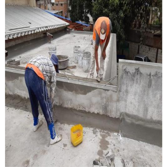
FUNDICION DE CONTRAPISO EN LOSA PARA SU POSTERIOR COLOCACION DEL
