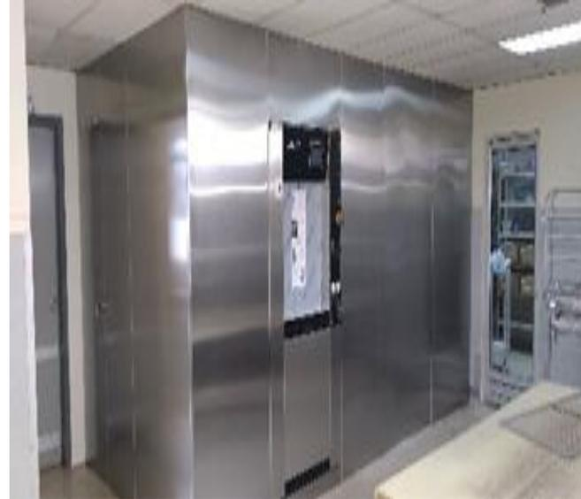
Cerramiento de área de máquinas de esterilización con material Linux para áreas blancas.
